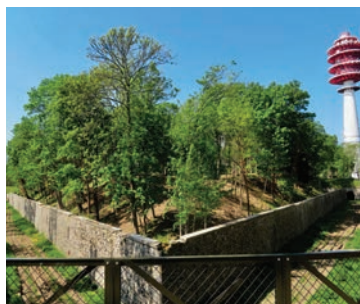
Aménagement du parc du Fort de Champigny
