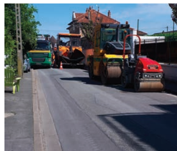
Réalisation de travaux d'enrobés
