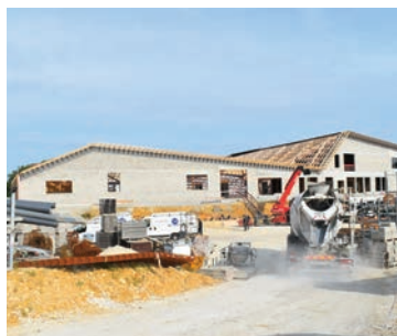
Construction du groupe scolaire Germaine Tillion et d'un équipement polyvalent
